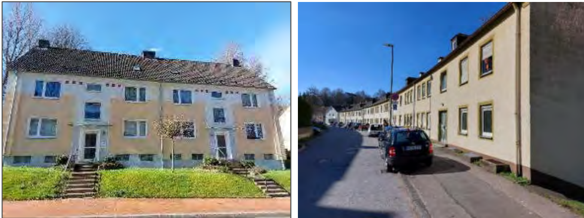
Abbildung 2-56: Gebäude im Bestand der Lüdenscheider Wohnstätten AG an der Brüderstraße und an der Elsa-Brandström-Straße (Quelle: eigene Darstellung; Kartengrundlage: ALKIS, Liegenschaftskataster NRW)
