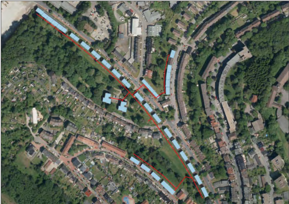
Abbildung 3-10: Wärmeverbund Gebäude der LüWo an der Brüderstraße
