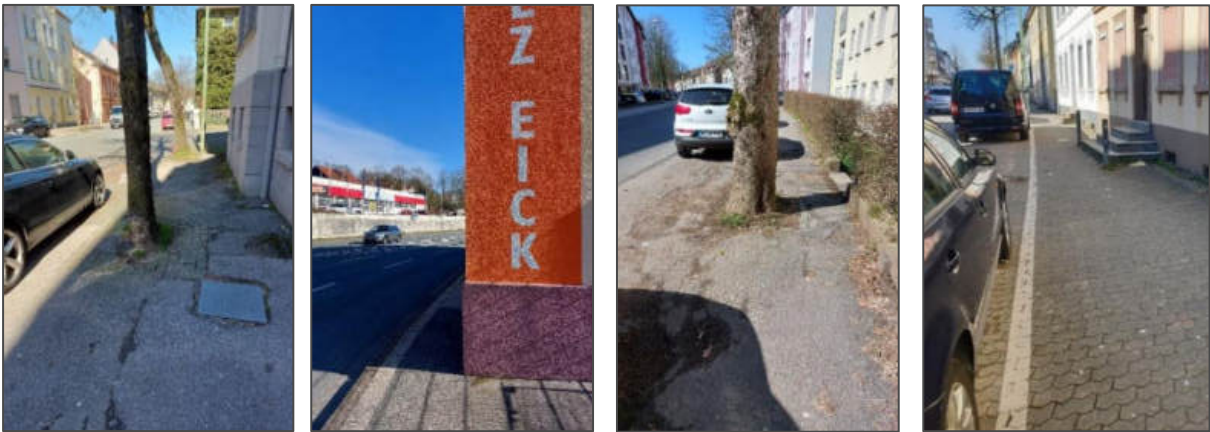
Abbildung 2-66: Mängel der Barrierefreiheit an Fußwegen im Quartier (Quelle: Eigene Aufnahmen 2023)
