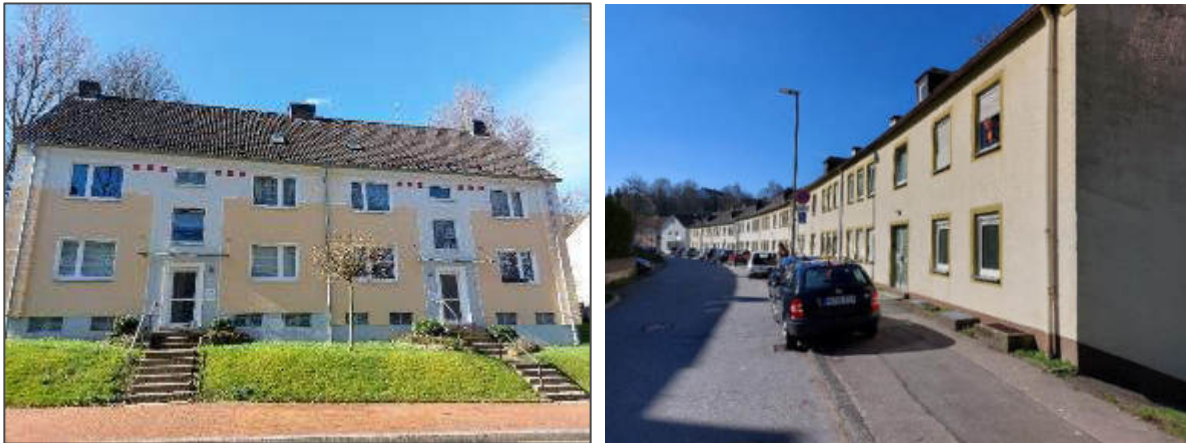
Abbildung 2-56: Gebäude im Bestand der Lüdenscheider Wohnstätten AG an der Brüderstraße und an der Elsa-Brandström-Straße (Quelle: eigene Darstellung; Kartengrundlage: ALKIS, Liegenschaftskataster NRW)
