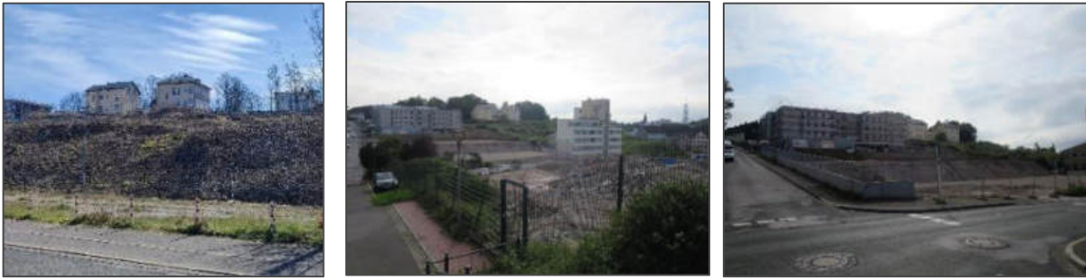
Abbildung 2-51: Vorhaben an der Wiesenstraße in der Umsetzung (Quelle: eigene Aufnahmen 2023)
