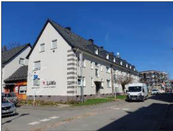
Abbildung 2-55: Gebäude der Lüdenscheider Wohnstätten AG an der Liebigstraße (Quelle: eigene Darstellung; Kartengrundlage: ALKIS, Liegenschaftskataster NRW)
